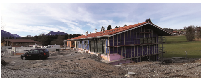
Der Kindergartenneubau nimmt Gestalt an.
